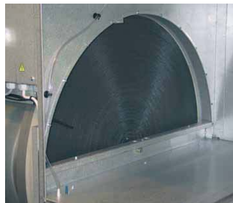
Wymiennik rotacyjny centrali GOLD RX.
