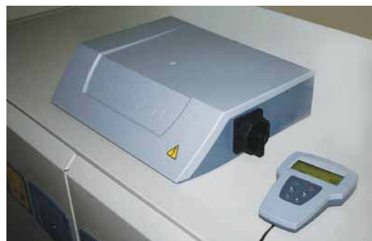
Skrzynka podłączeniowa zasilania elektrycznego oraz sterowania zewnętrznymi funkcjami GOLD o wielkościach 04-40 umieszczona jest na obudowie centrali.
