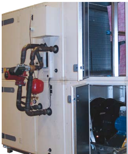
Układ regulacji przepływu glikolu w wymienniku jest sterowany przez układ automatyki centrali GOLD
