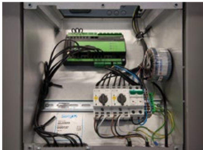
All el- och styrutrustning är samlad i särskild kapsling i aggregatets mittsektion.
