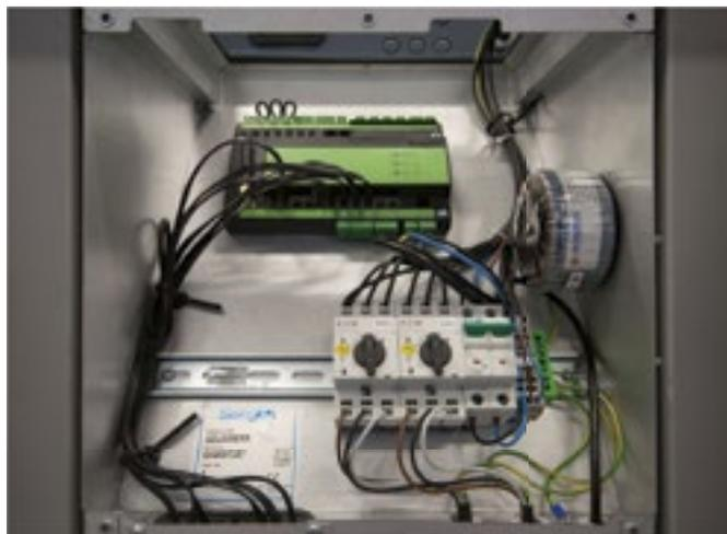
Tous les composants électriques et l'électronique de commande sont installés dans une armoire spéciale située dans le module central.
